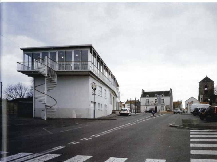
Vue de l'extension- surélévation posée directement sur l'existant.
