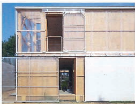
▲ Les terrasses sous serre sont des réserves de plancher cloisonnables.
